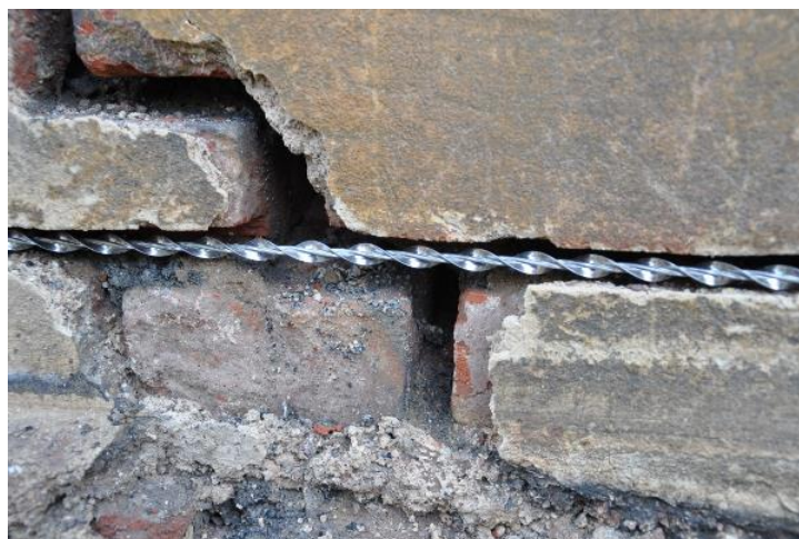
Przykład wykonania naprawy na murze ceglany
